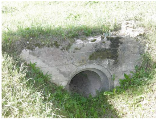
7. un 8. fotogrāfija “Skats uz caurtekas gala nostiprinājumiem un Ø 500 caurteku nobrauktuvē”
