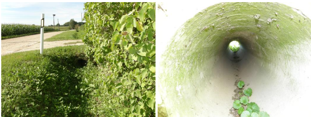
5. un 6. fotogrāfija “Skats uz caurtekas gala nostiprinājumiem un Ø 500 caurteku nobrauktuvē”
