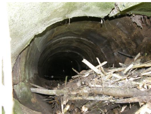
13. un 14. fotogrāfija “Skats uz caurtekas Ø800 bojājumiem un aizsērējumiem”
