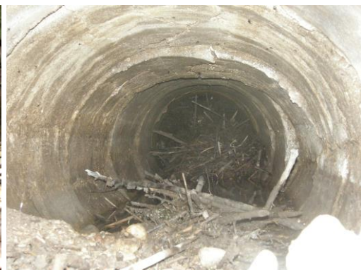
13. un 14. fotogrāfija “Skats uz caurtekas Ø800 bojājumiem un aizsērējumiem”
